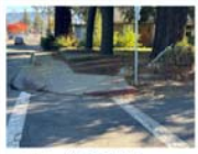
Install ADA Ramps
